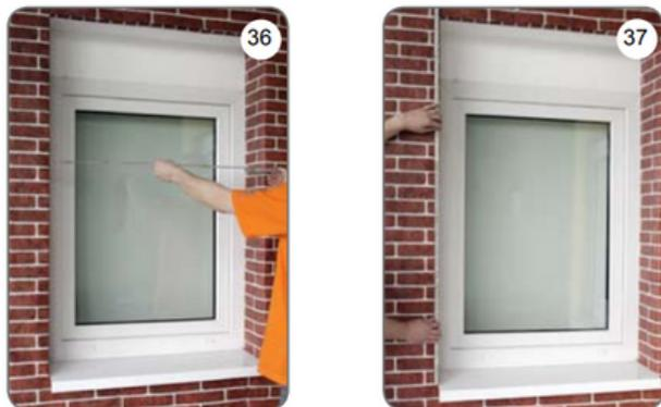
b) Marquer l'emplacement du trou pour la courroie ou le câble de commande manuelle (environ 17 mm au-dessus du bord du rail de guidage).
