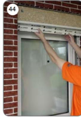
e) Abaisser le rideau du volet roulant sur le rebord de la fenêtre. Faire passer la courroie, (cordon) par le trou vers l'intérieur de la pièce [45]. Dans le cas d'un volet roulant avec moteur électrique, les butées doivent être réglées en plus (à l'aide du câble de montage) puis, connecter les éléments de commande selon les instructions de montage (moteur, unité de commande, driver, etc.). Faire sortir le câble d'alimentation conformément aux plans d'installation électrique.
