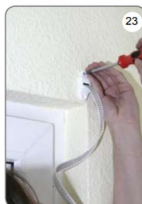
g) Retirer les goupilles de sécurité [24] et ouvrir l'enrouleur [25] en faisant levier sur un côté du boîtier avec un tournevis. Visser l'écarteur au cadre de la fenêtre
