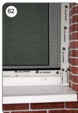
l) Après les travaux de plâtrage, retirer le film de protection du caisson [63] et des rails de guidage [64] ainsi que des autres éléments. Obturer les trous des rails de guidage [65].
