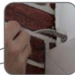
f) A l'intérieur, à la sortie du trou [46], monter le rail de guidage de la courroie (cordon) [47] à l'aide des vis [48].
