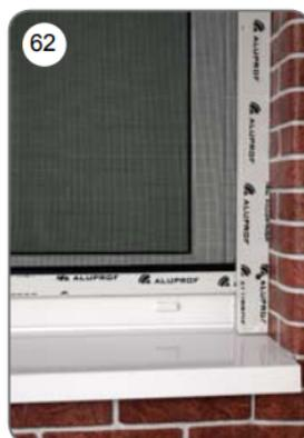
l) Una volta finito il processo d'intonacatura, rimuovere la pellicola protettiva dalla cassetta [63] e dalle guide [64] e dai restanti elementi. Tappare i fori nelle guide [65].
