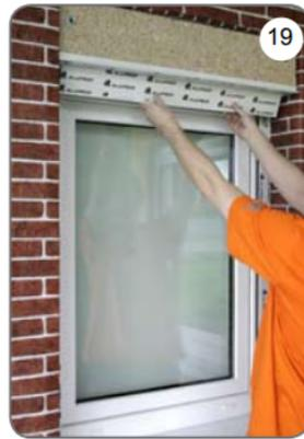
e) Abbassare la tendina della tapparella fino al davanzale. Far passare il nastro (il cavo) attraverso il foro verso l'interno della stanza [20]. Nel caso della tapparella con azionamento elettrico, bisogna regolare ulteriormente i fine corsa (con il cavo di montaggio), poi collegare gli elementi di comando seguendo le istruzioni di montaggio (montaggio di azionamento, unità di comando, controllore, ecc.). Togliere il cavo di alimentazione in conformità con i piani dell'impianto elettrico.
