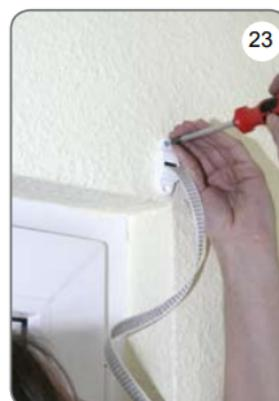
g) Togliere le coppie [24] e facendo leva da un lato dell'alloggiamento con un cacciavite - aprire l'avvolgitore [25]. Avvitare l'avvolgitore alla cornice della finestra con le viti [26]. Agganciare il nastro (il cavo) al gancio, tenendo stretto l'alloggiamento della molla ruotare e rilasciare il blocco [27]. Avendo l'avvolgitore montato e la tenda abbassata, bisogna avvolgere sulla molla 2-3 rotoli di nastro/cavo [28]. Chiudere l'alloggiamento dell'avvolgitore [29].
