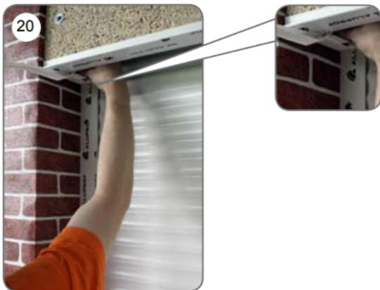
f) Dall'interno, all'uscita del foro [21], montare la guida del nastro [22] utilizzando le viti [23].
