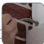
f) Dall'interno, all'uscita del foro [46], montare la guida del nastro (cavo) [47] utilizzando le viti [48]
