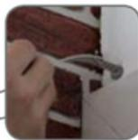
f) Montieren Sie auf der Innenseite am Lochausgang [46] die Riemenführung (String) [47] mit Schrauben [48].
