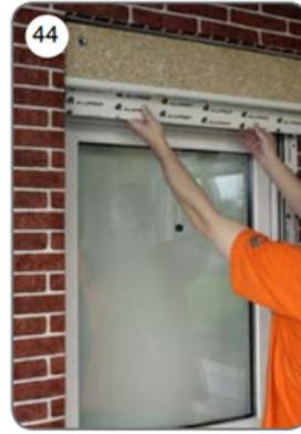
e) Senken Sie den Rollladenpanzer auf die Fensterbank. Führen Sie das Band (Kabel) durch die Öffnung in den Raum [45]. Bei Rollläden mit elektrischem Antrieb sind zusätzlich Endanschläge einzustellen (mittels Montagedraht) und anschließend die Steuerelemente gemäß Montageanleitung anzuschließen (Antrieb, Steuerung, Regler etc.). Führen Sie das Stromkabel gemäß den Elektroinstallationsplänen aus.
