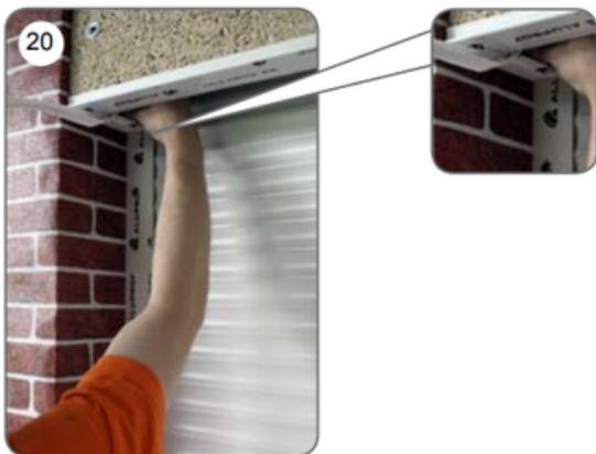
f) Auf der Innenseite am Lochausgang [21] die Riemenführung (Schnur) [22] mit Schrauben [23] montieren.
