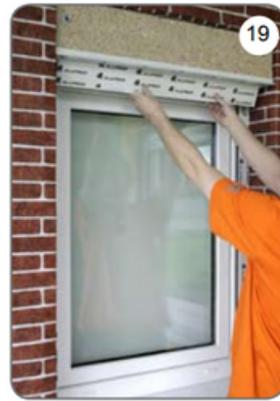
e) Senken Sie den Rollladenpanzer auf die Fensterbank. Führen Sie das Band (Kabel) durch die Öffnung in den Raum [20]. Bei elektrisch betriebenen Rollläden sind zusätzlich Endschalter einzustellen (mittels Montagedraht) und anschließend Steuerelemente gemäß Montageanleitung anzuschließen (Aktor, Steuergerät, Mitnehmer usw.). Führen Sie das Stromkabel gemäß den Elektroinstallationsplänen aus.
