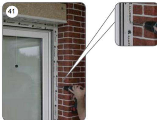
d) Schrauben [42], [43] entfernen und Inspektionsdeckel der Box [44] öffnen.
