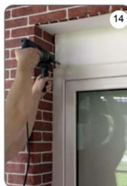
c) Stellen Sie die Jalousie auf den Boden [15], richten Sie die Führungen senkrecht aus und verschrauben Sie sie mit dem Fensterrahmen [16].
