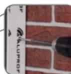
d) Schrauben [17], [18] entfernen und Inspektionsdeckel der Box [19] öffnen.
