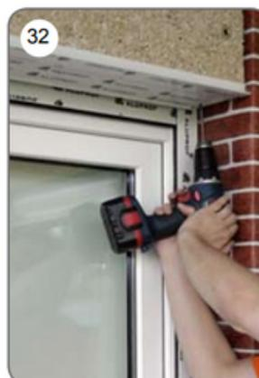
k) Nach dem Verputzen Schutzfolie von Kasten [33] und Führungen [34] und anderen Bauteilen entfernen. Verschießen Sie die Löcher in den Führungen [35].
