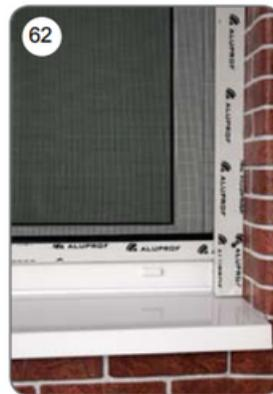
l) Entfernen Sie nach der Verputzbehandlung die Schutzfolie vom Kasten [63] und den Führungen [64] sowie von den anderen Bauteilen. Verschließen Sie die Löcher in den Führungen [65].
