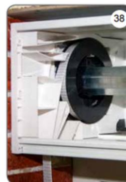
w) Après le séchage de la mousse de montage, abaisser le rideau du volet roulant sur l'appui de fenêtre, ouvrir le couvercle d'inspection du caisson [36] sortir les éléments d'isolation [37] vérifier l'état des raccords des suspensions avec le tube d'enrouleur et le rideau [38].
