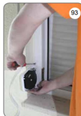
x) Retirer les goupilles [91] et ouvrir l'enrouleur [92] en faisant levier sur un côté du boîtier avec un tournevis.
