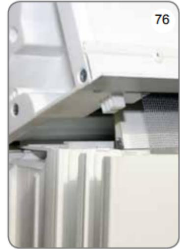
m) Sur les bords extérieurs du profilé de l'adaptateur, marquer les points de chevauchement des guides sur le profilé, qui doivent être retirés à l'emplacement suivant Cela peut être fait avant de visser le profilé au cadre de la fenêtre [74], [75].
