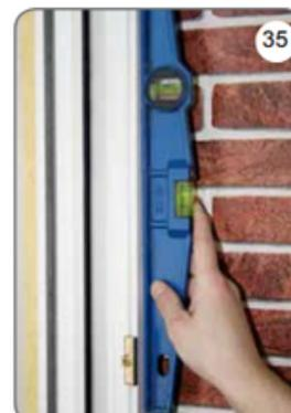
u) L'installation de la fenêtre et du volet roulant doit être effectuée conformément aux normes et pratiques de construction en vigueur. Montez la fenêtre avec le volet roulant dans l'ouverture de la fenêtre à l'aide d'ancrages ou de vis comme recommandé par le fabricant de la fenêtre [33], [34], [35].
