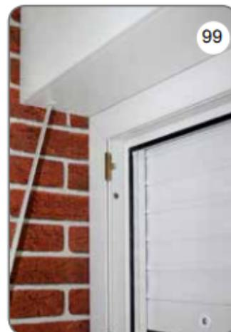
z) Tirer le rideau du volet roulant dans le caisson, insérer les éléments d'isolation un par un, vérifier le bon positionnement par rapport au rideau. Fermer le couvercle d'inspection du caisson [98], [99]. Retirer le film de protection du caisson et des coulisses et des autres éléments. Former l'utilisateur au fonctionnement du volet roulant. Fournir à l'utilisateur les instructions d'utilisation et de maintenance, garantir et signer le protocole de réception.
