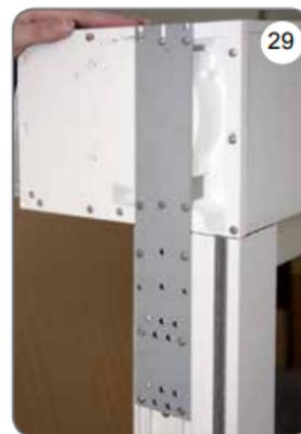
s) Après avoir vissé les connecteurs, le caisson doit être placé perpendiculairement au cadre de la fenêtre et vissé, en faisant attention à l'alignement des deux éléments. Pour le vissage, on peut utiliser les vis mentionnées ci-dessus ou des vis autoperceuses des vis à tête plate choisies de manière appropriée en fonction de l'épaisseur du cadre de la fenêtre, afin d'obtenir une fiabilité maximale de la connexion du volet roulant avec la fenêtre [28].
