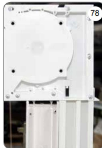
q) Après avoir installé le caisson sur la fenêtre, vérifier les joints à brosse dans les guides et, si nécessaire, les empêcher de tomber (collage supplémentaire). Les guides doivent être solidement fixés au bord inférieur du caisson [77], [78].
