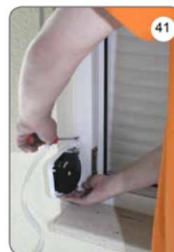
x) Retirer les goupilles de verrouillage [39] et ouvrir l'enrouleur [40] en faisant levier sur un côté du boîtier avec un tournevis. Vissez l'enrouleur au cadre de la fenêtre à l'aide des vis [41]. Accrochez la bande sur le loquet en tenant fermement le boîtier à ressort, tournez et libérez le verrou [42]. Lorsque l'enrouleur est installé et que le rideau est abaissé, 2-3 rouleaux de ruban [43] doivent être enroulés sur le tambour à ressort. Fermez le boîtier de l'enrouleur [44].
