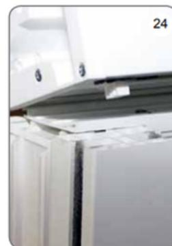
m) Sur les bords extérieurs du profilé adaptateur, marquer les endroits où les rails de guidage chevauchent le profilé, qui doivent être retirés sans faute. Cela peut être fait avant de visser le profilé au cadre de la fenêtre [22], [23].
