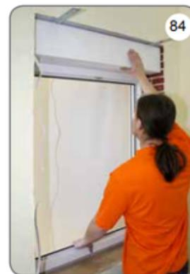
t) En fonction de la méthode de montage de la fenêtre avec volet roulant sur le linteau, le nombre approprié d'ancrages de montage KMO doivent être insérés dans les évidements du profil supérieur du caisson PSG [82], [83], [84].
