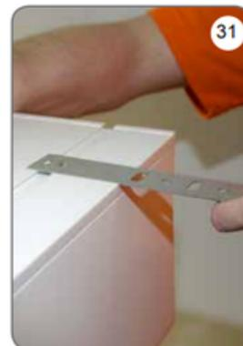
t) En fonction de la méthode de montage de la fenêtre avec volet roulant sur le linteau, il faut installer un nombre approprié d'ancrages de montage. KMO dans les évidements du profil supérieur du coffre PSG [30], [31], [32].
