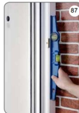
u) L'installation de la fenêtre et du volet roulant doit être effectuée conformément aux normes et pratiques de construction en vigueur. la fenêtre et le volet roulant dans l'ouverture de la fenêtre à l'aide de chevilles ou de vis selon les recommandations du fabricant de la fenêtre [85], [86], [87].
