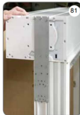
s) Après avoir vissé les connecteurs, le caisson doit être placé perpendiculairement au cadre de la fenêtre et vissé, en faisant particulièrement attention à l'alignement des deux éléments.
