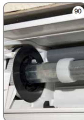
w) Après le séchage de la mousse de montage, abaisser le rideau du volet roulant jusqu'à l'appui, ouvrir le couvercle d'inspection du caisson [88] sortir les éléments de l'isolation [89] et vérifier la présence de l'isolant.
