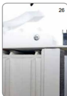
q) Après avoir installé le caisson sur la fenêtre, vérifiez les joints à brosse dans les guides et, si nécessaire, fixez-les contre les chocs spontanés. (collés en plus), puis faites glisser les guides dans le caisson. Les guides doivent être bien ajustés. Les guides doivent s'appuyer fermement sur le bord inférieur du caisson [25], [26].
