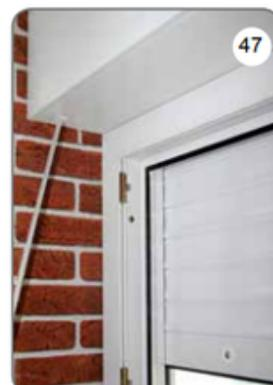
z) Tirez le rideau du volet roulant dans le caisson, insérez les éléments d'isolation un par un, vérifiez le bon positionnement par rapport au rideau. Fermez le couvercle d'inspection du caisson [46], [47].
