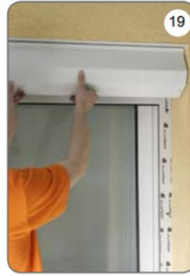
e) Abaisser le rideau du volet roulant sur l'appui de fenêtre et visser le coffre au sol (des deux côtés) [20]. Faire passer le ruban (cordon) par l'ouverture dans la pièce [21]. Dans le cas d'un volet roulant à commande électrique, il convient d'effectuer les réglages supplémentaires suivants
