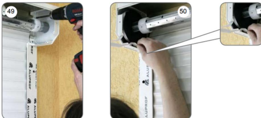
g) A l'intérieur, à la sortie du trou [51], monter le guide-courroie (câble) [52] avec les vis [53].
