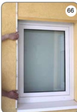
c) Poser le store sur le sol [69], ajuster les guides verticalement et les visser au cadre de la fenêtre [70].
