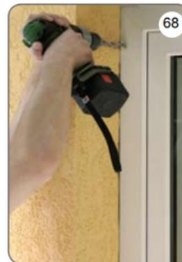
b) Marquer l'emplacement du trou pour la courroie ou le câble de commande manuelle (environ 17 mm au-dessus du bord de guidage) [67], puis percer un trou [68].
