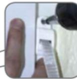
g) Retirer les goupilles [78] et en faisant levier sur un côté du boîtier avec un tournevis - ouvrir l'enrouleur [79]. Visser l'enrouleur au cadre de la fenêtre à l'aide des vis [80]. Fixer le ruban (câble) au loquet en tenant fermement le boîtier du ressort, tourner et relâcher le verrou [81]. Avec l'enrouleur monté et le rideau abaissé sur le tambour à ressort, enrouler 2-3 bobines de la sangle / du câble [82]. Fermer le boîtier de l'enrouleur [83].
