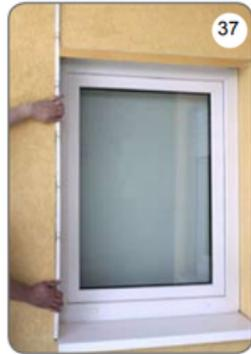
b) Poser le guide sur le sol et l'aligner verticalement [38]. Marquer l'emplacement du trou pour la courroie ou le câble du volant à main pour l'entraînement du volet (à environ 17 mm au-dessus du bord du guide) [39], puis marquer l'emplacement des trous à percer pour le câble du volet. Visser le guide [40].
