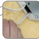
f) A l'intérieur, à la sortie de l'ouverture [76], monter le guide bande (cordon) [77] au cadre de la fenêtre à l'aide de vis. (cordon) [77].
