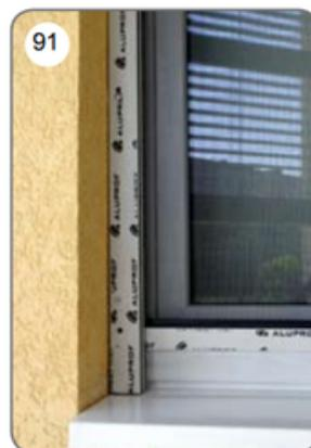
l) Retirer la feuille de protection du caisson [92] et des guides [93] et autres composants. Sceller les trous des guides [94].
