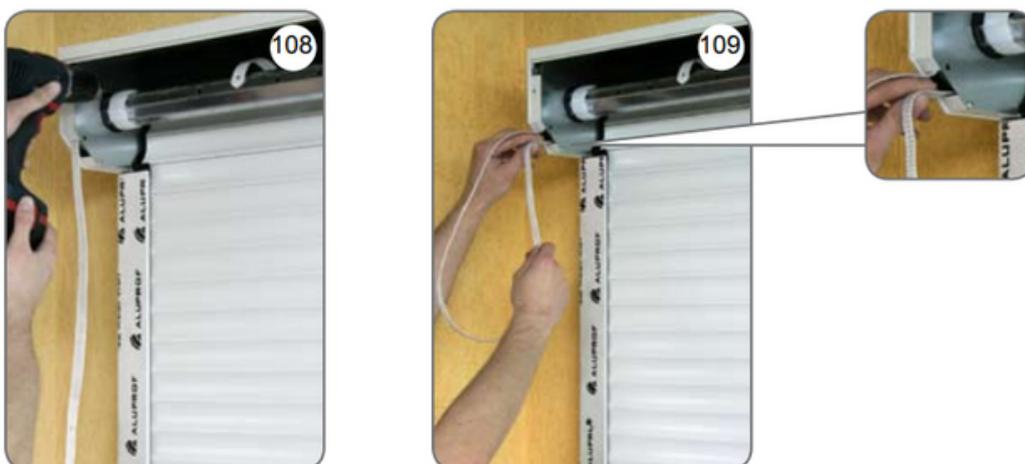
g) Sur le côté intérieur, à la sortie du trou [110], monter le guide-courroie (câble) [111] avec les vis [112].
