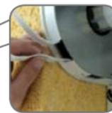
f) A l'intérieur, à la sortie de l'ouverture [76], monter le guide bande (cordon) [77] au cadre de la fenêtre à l'aide de vis.
