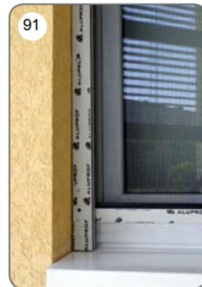
l) Retirer la feuille de protection du caisson [92] et des guides [93] et autres composants. Fixer les capuchons des guides [94].
