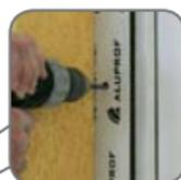
d) Desserrer les vis [17], [18] et ouvrir le coffre du volet roulant (bas) [19].
