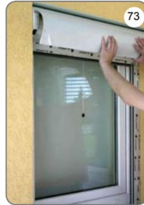
e) Abaisser le rideau du volet roulant sur le rebord de la fenêtre et visser le coffre au sol (des deux côtés) [74]. Faire passer le ruban (cordon) par l'ouverture dans la pièce [75]. Dans le cas d'un volet roulant à commande électrique, il convient d'effectuer les réglages supplémentaires suivants
