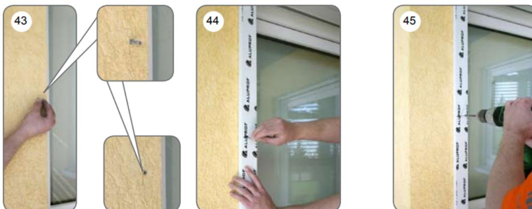
e) Placer le caisson du volet roulant (avec le deuxième rail) sur le mur [46], le positionner comme le premier rail, marquer les points de perçage, percer les trous de fixation [46] et visser au sol [45]. guide, marquer les points de perçage, percer les trous, insérer les chevilles et visser le tout au sol. Dévisser ensuite les vis [47] et ouvrir le coffre du volet roulant (en bas) [48].
