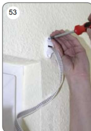
h) Retirer les vis [54] et, à l'aide d'un tournevis, ouvrir l'enrouleur [55]. Accrocher la bande (câble) sur le clip, en tenant fermement le boîtier à ressort, tourner et relâcher le dispositif de verrouillage [57]. Une fois l'enrouleur installé et le rideau abaissé, il faut enrouler sur le tambour à ressort 2 à 3 bobines de courroie / cordon [58]. Fermer le boîtier de l'enrouleur [59].
