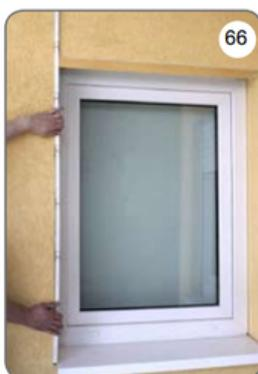
c) Stellen Sie die Jalousie auf den Boden [69], richten Sie die Führungen senkrecht aus und verschrauben Sie sie mit dem Fensterrahmen [70].
