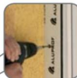
d) Schrauben [17], [18] herausdrehen und Rollladenkasten (unten) [19] öffnen.
