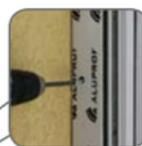
d) Lösen Sie die Schrauben [71], [72] und öffnen Sie den Rollladenkasten (unten) [73].
