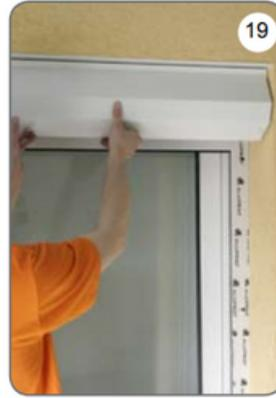
e) Senken Sie den Rollladenpanzer auf die Schwelle und verschrauben Sie den Kasten mit dem Boden (von beiden Seiten) [20]. Führen Sie das Band (Kabel) durch die Öffnung in den Raum [21]. Bei Rollläden mit elektrischem Antrieb sind zusätzlich Endschalter einzustellen (mittels Montagendraht) und anschließend die Steuerelemente gemäß Montageanleitung anzuschließen (Antrieb, Steuerung, Regler etc.). Führen Sie das Stromkabel gemäß den Plänen für die Elektroinstallation aus.
