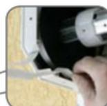
g) Montieren Sie auf der Innenseite am Lochausgang [51] die Riemenführung (Kabel) [52] mit Schrauben [53].
