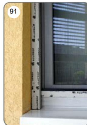
l) Entfernen Sie die Schutzfolie vom Gehäuse [92] und den Führungen [93] sowie den anderen Bauteilen. Verschließen Sie die Löcher in den Führungen [94].
