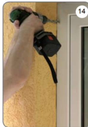
c) Setzen Sie die Jalousie auf den Sockel [15], positionieren Sie die Führungen vertikal und schrauben Sie sie mit den Schrauben [16] am Fensterrahmen fest.
