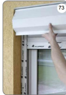
e) Senken Sie den Rollladenpanzer auf die Fensterbank und schrauben Sie den Kasten am Boden fest (auf beiden Seiten) [74]. Führen Sie das Band (die Schnur) durch die Öffnung in den Raum [75]. Bei Rollläden mit elektrischem Antrieb sind zusätzlich Endschalter einzustellen (mittels Montagedraht) und anschließend die Steuerelemente gemäß Montageanleitung anzuschließen (Antrieb, Steuerung, Regler etc.). Führen Sie das Stromkabel gemäß den Verdrahtungsplänen heraus.
