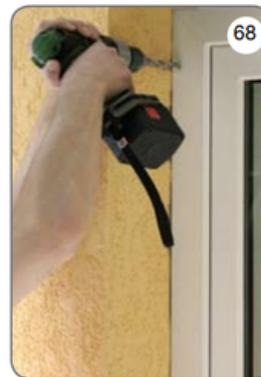
b) Markieren Sie die Stelle für die Bohrung für den Riemen oder das Handantriebsseil (ca. 17 mm über der Führungskante) [67] und bohren Sie dann ein Loch [68].
