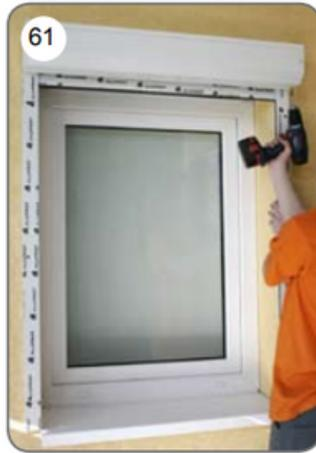
l) Entfernen Sie die Schutzfolie von der Box [62] und den Führungen [63] und den anderen Bauteilen. Verschieben Sie die Löcher in den Führungen [64].
