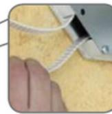
f) Auf der Innenseite am Ausgang der Öffnung [76] die Bandführung (Schnur) [77] mit Schrauben am Fensterrahmen befestigen.
