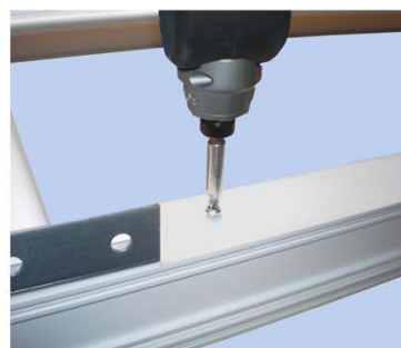
Nippelschrauben positionieren
